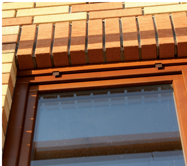
Внешний вид кладки с использованием перемычек BRICKO
