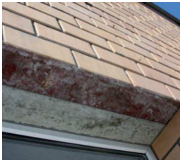
Внешний вид кладки без применения перемычек BRICKO
